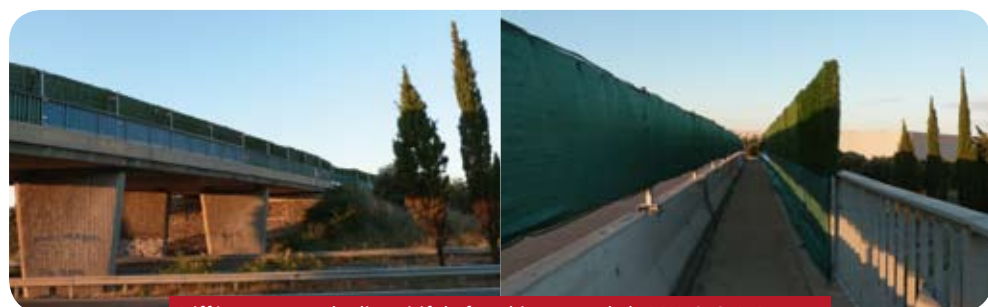
Différentes vues du dispositif de franchissement de la RN113. © A. Renaux
