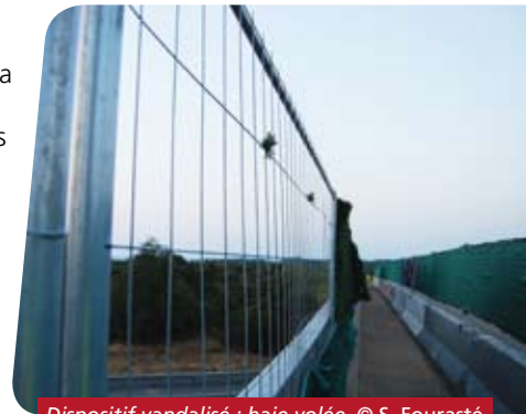
Dispositif vandalisé : haie volée. © S. Fourasté
