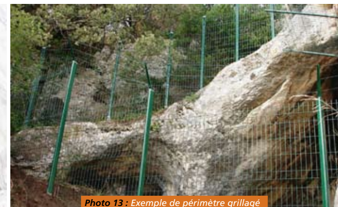
Photo 13 : Exemple de périmètre grillagé entourant les accès aux cavités.
