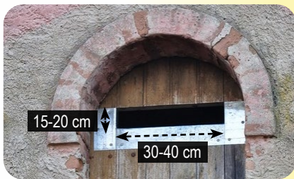
Ouverture type « boîte aux lettres » dans une porte existante (Emmanuel Cosson).
